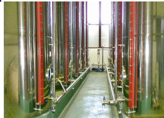
Almacenamiento en tanques de acero inoxidable
